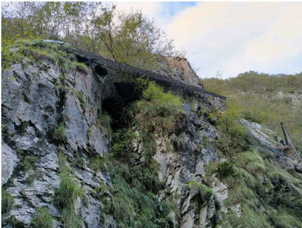
Vista dal lato di valle delle due campate stese a terra della barriera paramassi esistente.
