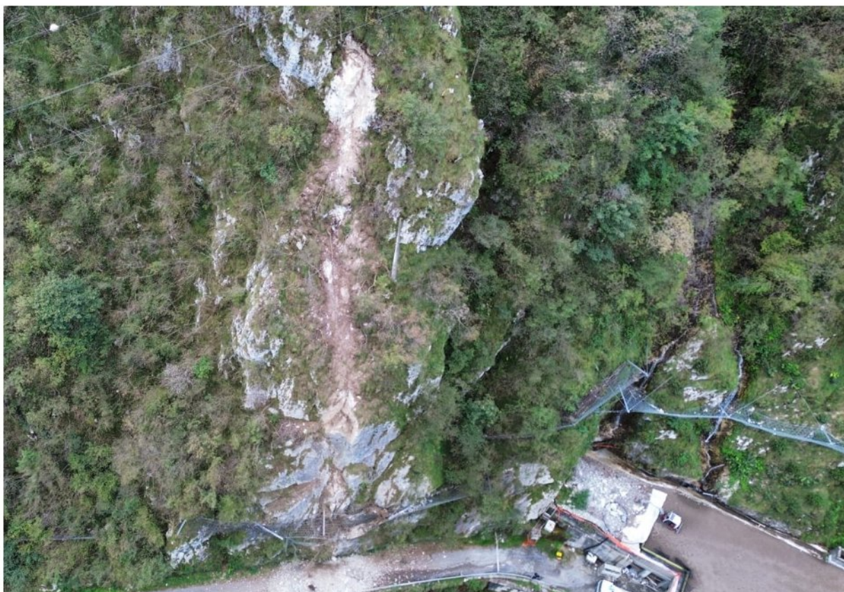
Vista dall'alto della nicchia di frana superiore e degli punti di distacco posti a valle.
