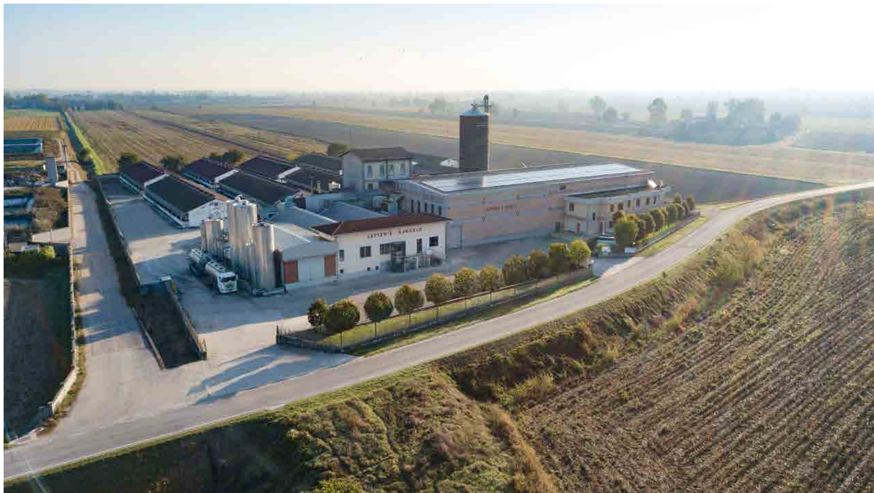
Veduta aerea del Caseificio Sant'Angelo che partecipa al progetto “ResilientGranaPadano. In apertura il taglio delle forme gemelle in caldaia nel Caseificio San Donato
