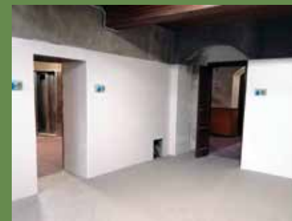
I locali interni ristrutturati.
