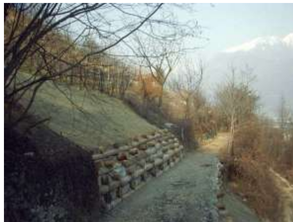
Intervento di ingegneria naturalista per recuperare viabilità interessata da frana (foto - Associazione CF lombardi)
