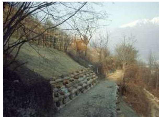
Intervento di ingegneria naturalista per recuperare viabilità interessata da frana
