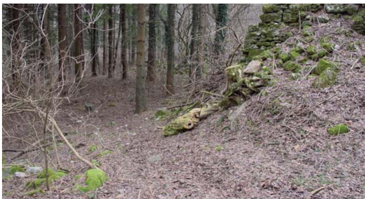
A lato, dall'alto: la zona del barch (recinto del bestiame) prima e dopo i lavori
