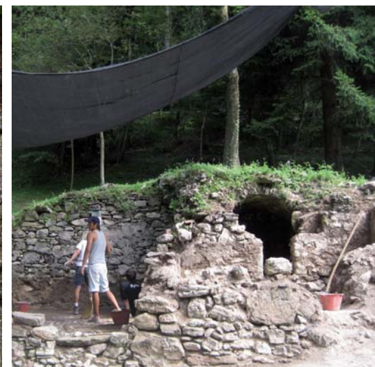
Cà Martina durante i lavori di recupero, estate 2011
