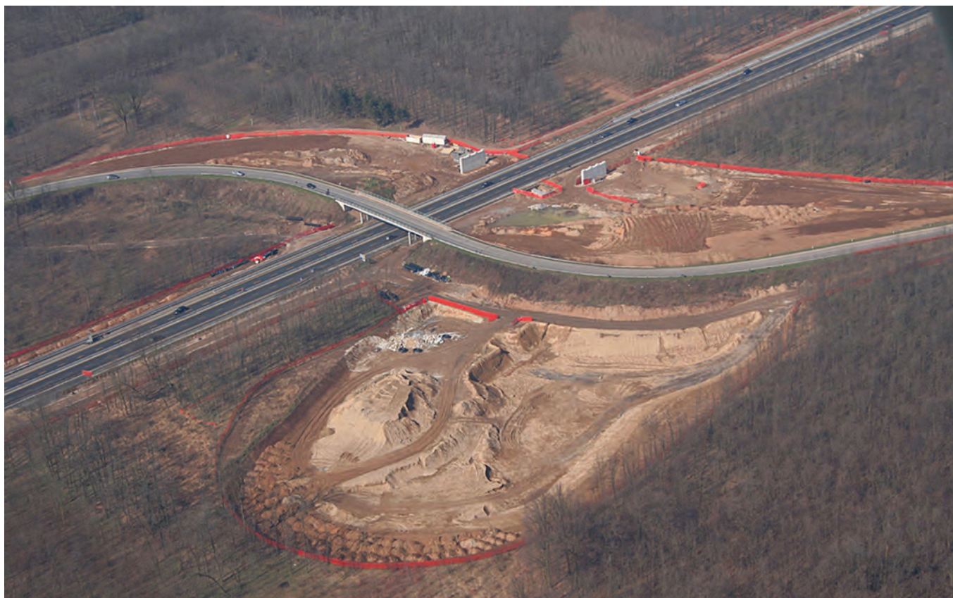
Figura 4 Lavori di realizzazione di un nuovo asse stradale inserito in un'area boscata in provincia di Como (Maurizio Pucci, 2011)
