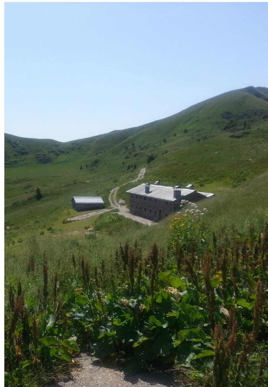
Fabbricato di malga di recente ristrutturazione
