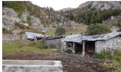
Esempi di situazioni problematiche
