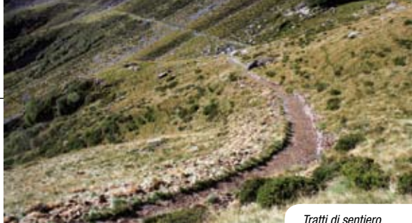
Tratti di sentiero ripristinati lungo la Linea Cadorna
