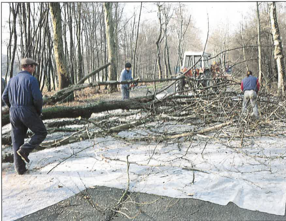
Abbattimento di platani affetti da cancro colorato: il cantiere per tale operazione risulta complesso ed oneroso per la presenza di teli di plastica che evitano la dispersione del materiale infetto nell'ambiente circostante.
