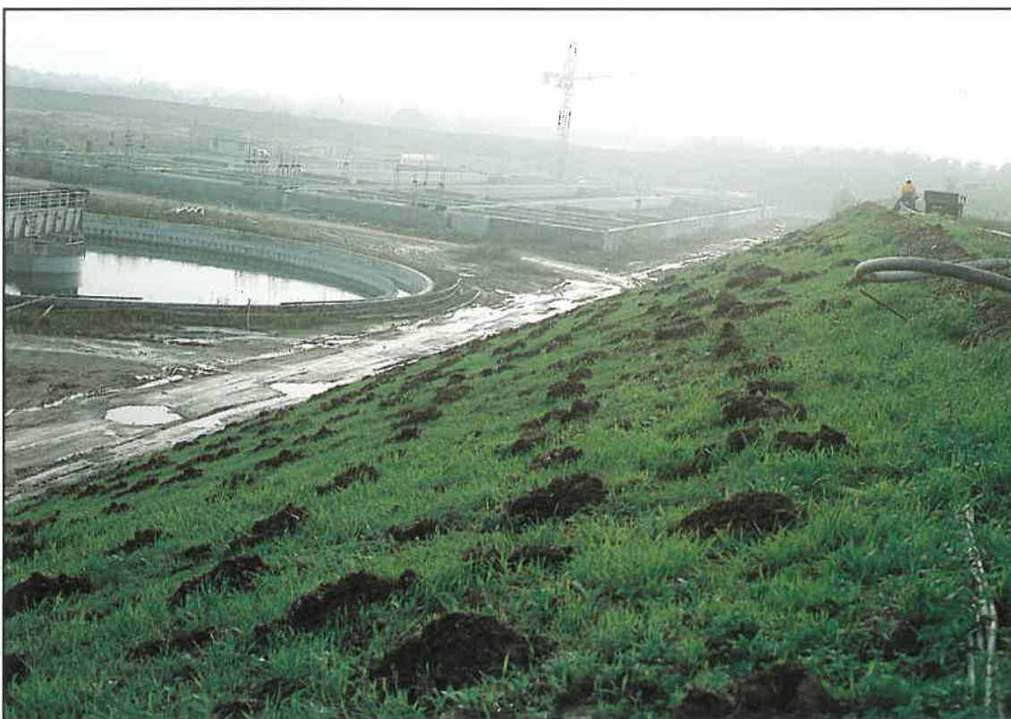
Recupero ambientale dell'area del depuratore di Pero (MI): causa la pendenza, la maggior parte delle buche viene eseguita manualmente. Contestualmente viene realizzato l'impianto di irrigazione semi fisso, per i successivi interventi di manutenzione.
