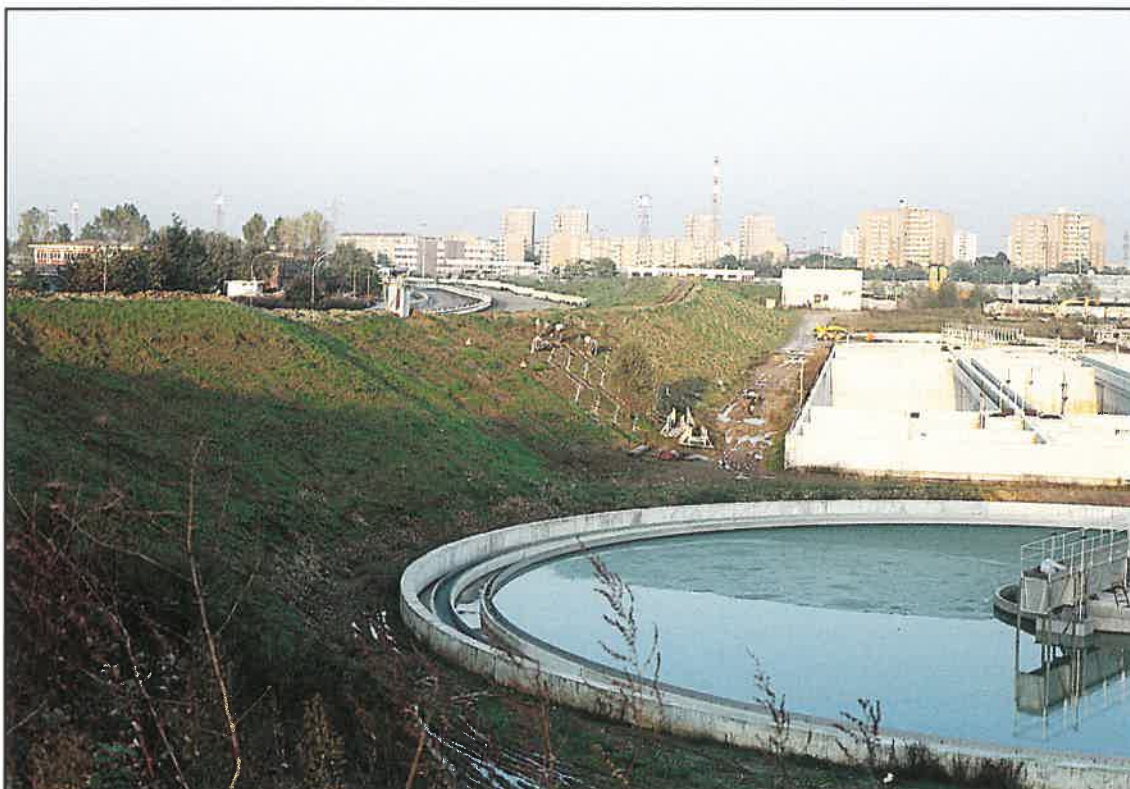
Recupero ambientale delle pertinenze del depuratore di Pero (MI): forestazione del terrapieno che delimita l'area del depuratore.
