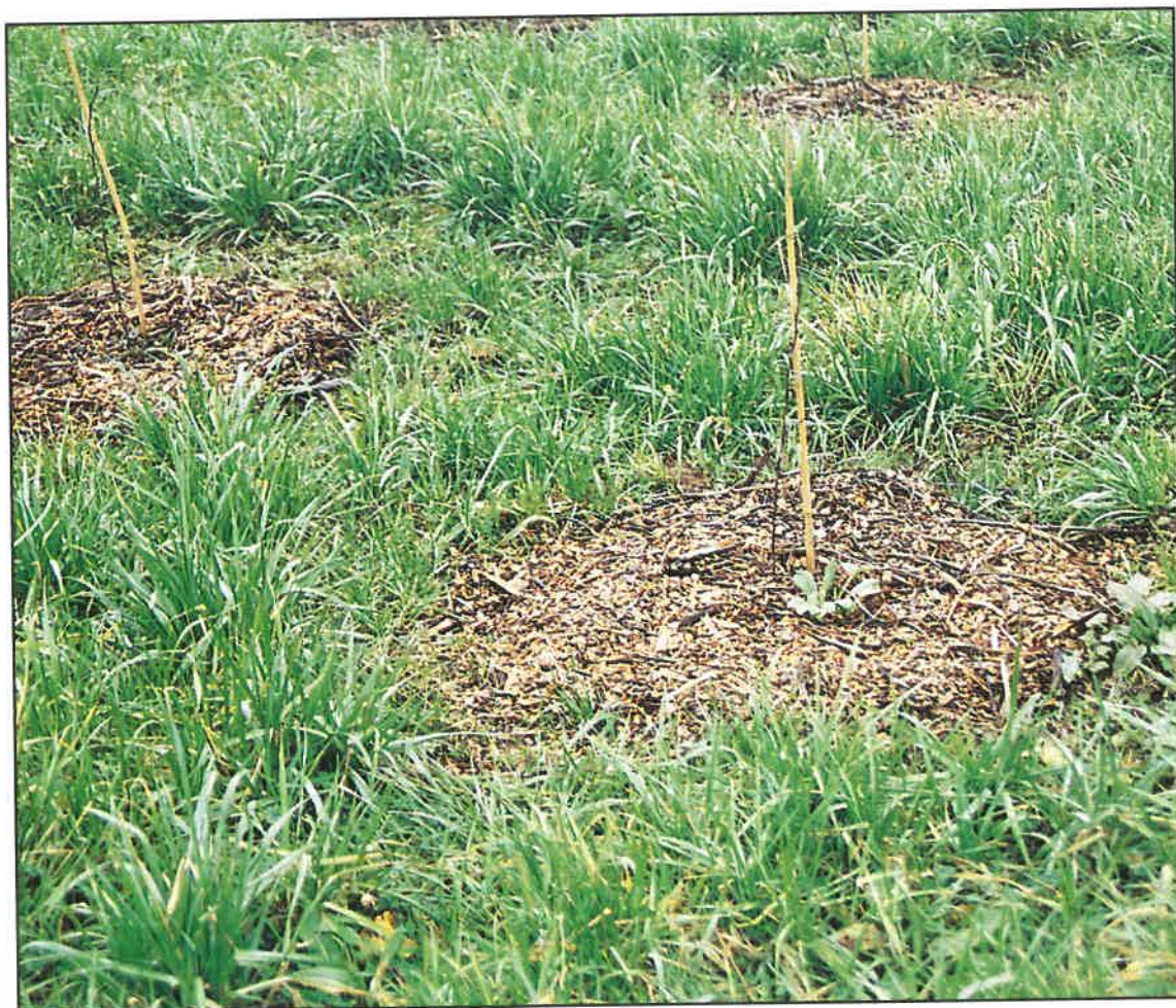
Messa a dimora su discarica di giovani piante di due anni in contenitore con pacciamatura di trucioli di legno di 50 cm di raggio e di 8-10 cm di spessore (Discarica di Carate Brianza).
