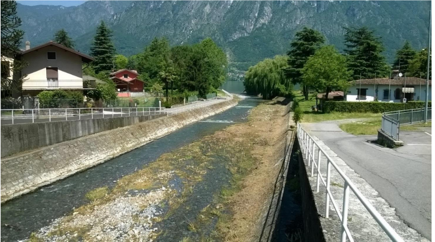
Fig.2 – pulizia della vegetazione in alveo nel tratto urbano
