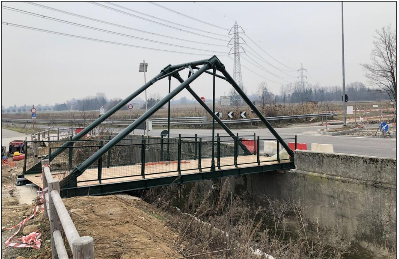
Lavori di posa conclusi
