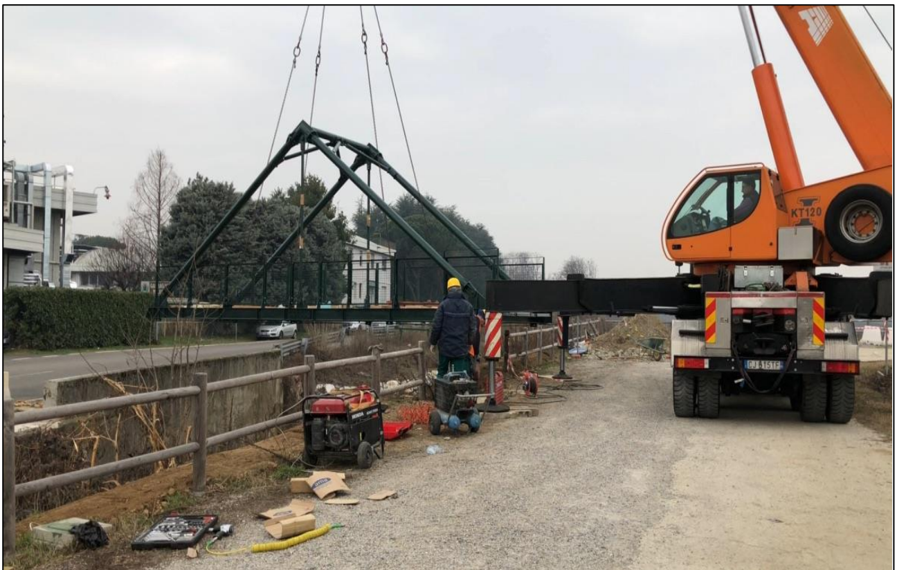
Posa della passerella
