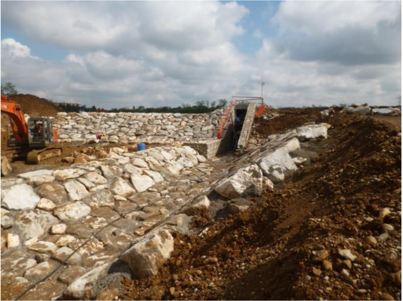
Manufatto di regolazione e sfioro di sicurezza in massi
