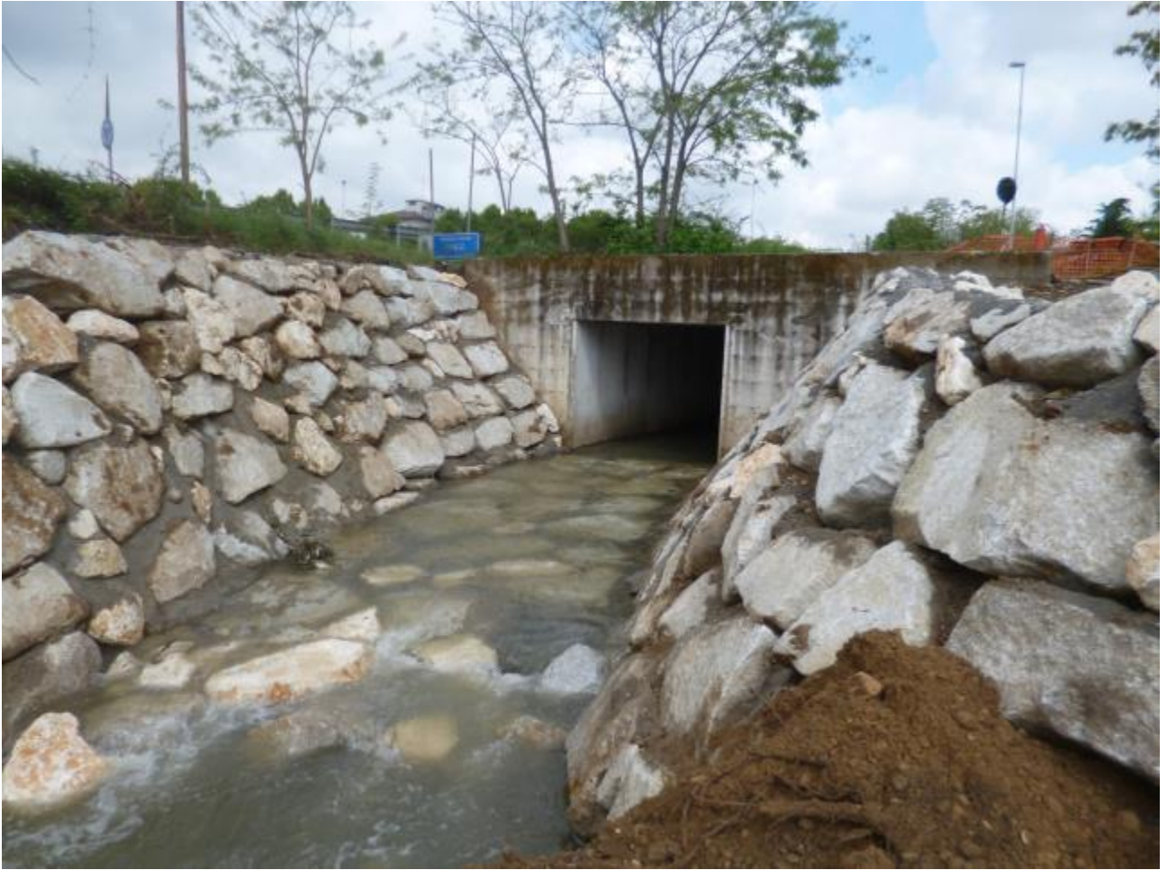
Manufatto di imbocco in corso di esecuzione
