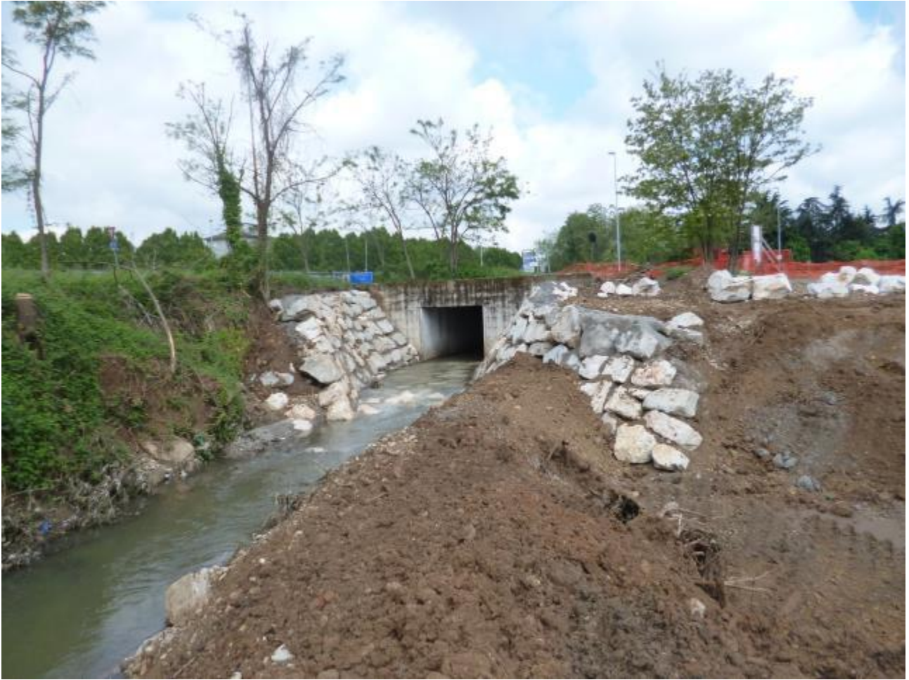
Manufatto di imbocco in corso di esecuzione (per l'ultimazione serve lo spostamento della fognatura)
