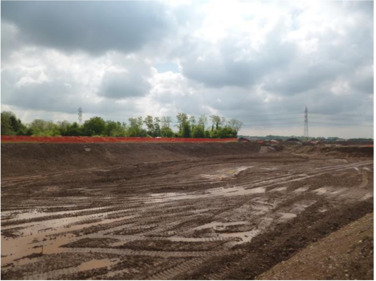
Vasca di laminazione I comparto, foto da monte verso valle
