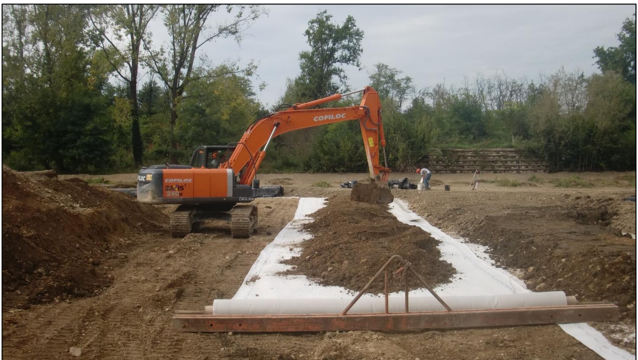
Impermeabilizzazione dell'area umida con materassino bentonitico
