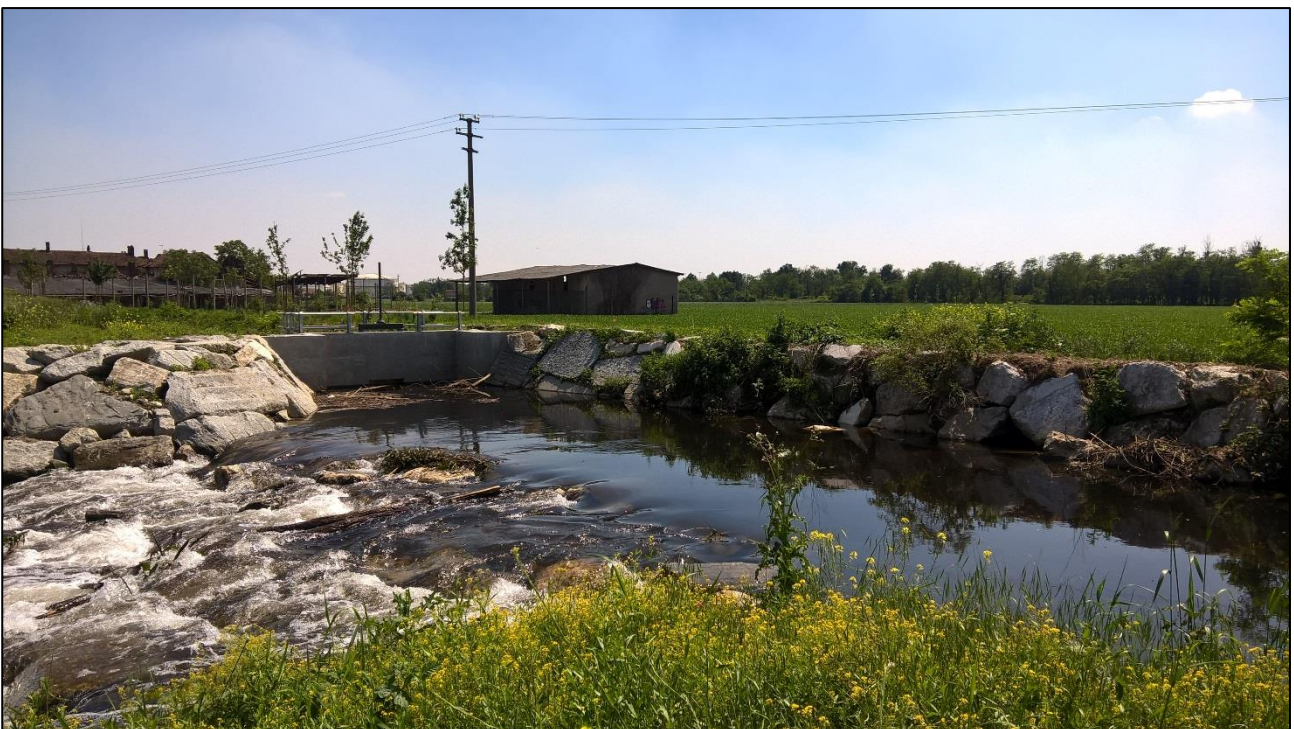
Nuova opera di presa sulla roggia Molinara
