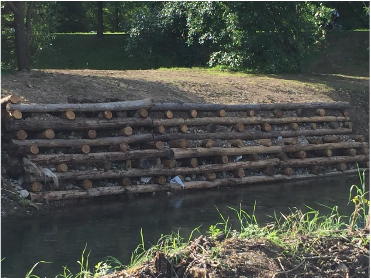
Figura 3 - stabilizzazione delle sponde
