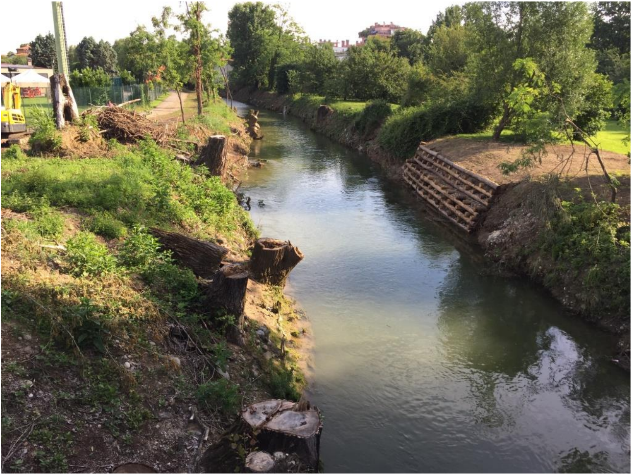
Figura 4- sistemazione delle sponde e taglio selettivo piante ad alto fusto
