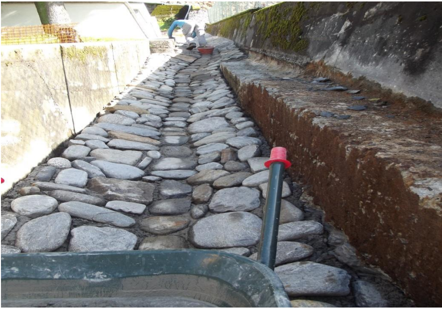
- ricostruzione alveo nella Valle Botticello
